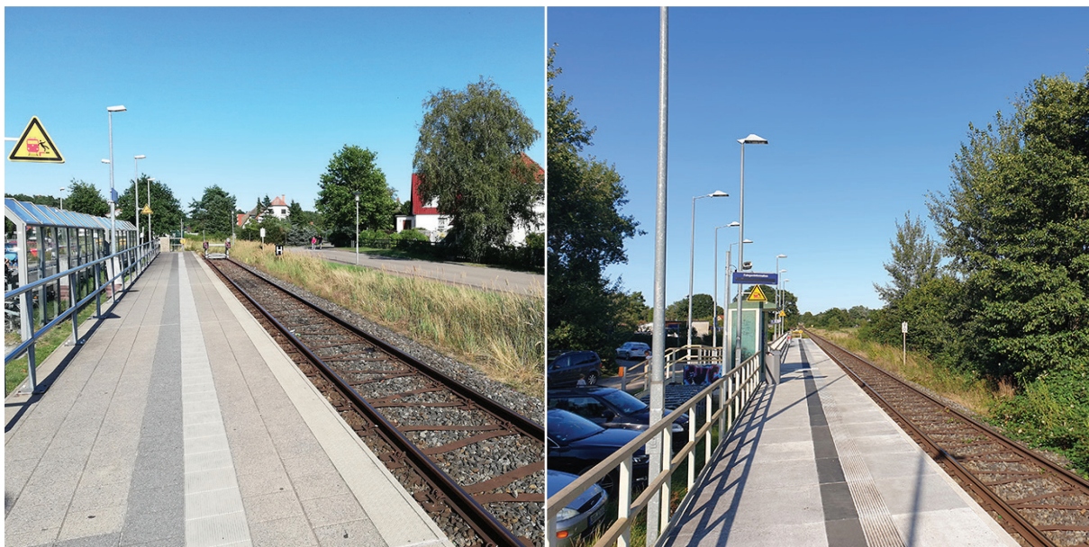
62 | Bahnhof „Graal-Müritz“ und Bahnhof „Graal-Müritz Koppelweg“
