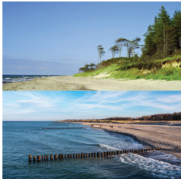
55 | Buhnen und Küstenwald als Hochwasserschutz in Graal-Müritz
