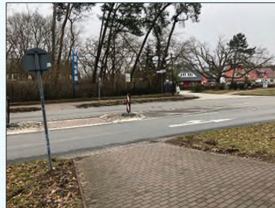
Abb. 2: Bereich „Ribnitzer Straße / Wendenstraße“
