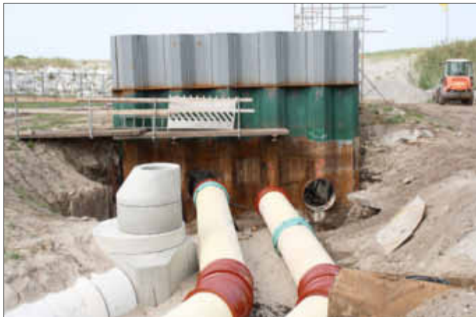
Die Aufstockung des Zwischenbehälters um 160 cm ist erfolgt, die Rohrverbindungen vom Schöpfwerk zum Behälter wurden vorbereitet.
