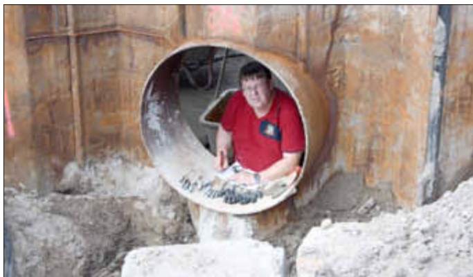
Polier Detlef Höpfner beim Überprüfen und Vermessen des Behälters.
