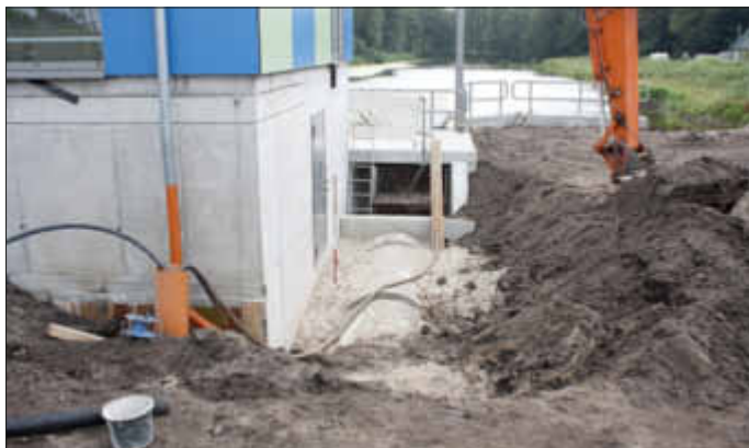
Baggerarbeiten zum Geländeausgleich und zur Rohrgrabenverfüllung. Fotos: K. Graf
