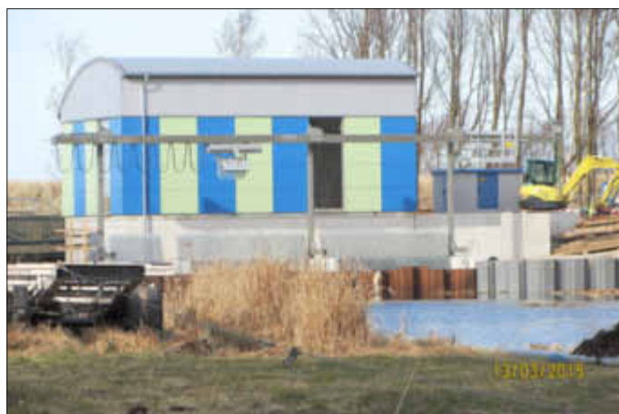
An der Südseite sind die Einlaufgitter und der Reinigungsrechen montiert.
