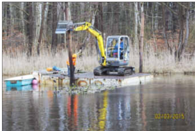
Zum Entkrauten kleiner Bagger auf einem Ponton.
