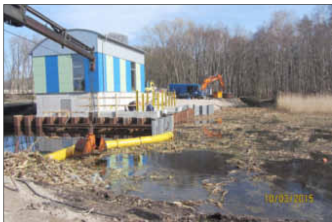
Vor der Schwimmsperre sammeln sich die dicken Wurzeln.
