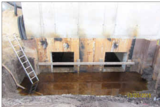
Die Durchbrüche für Pumpe 3 und 4
