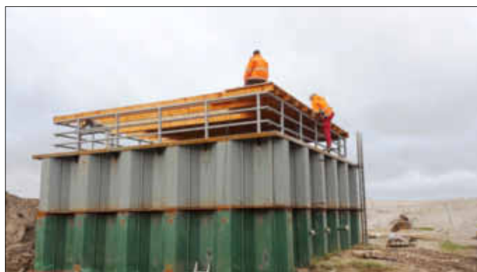
Bei stürmischem Wetter wird der Zwischenbehälter überdacht.
