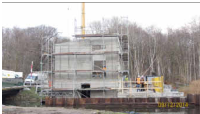
Der Rohbau ist fertig.
