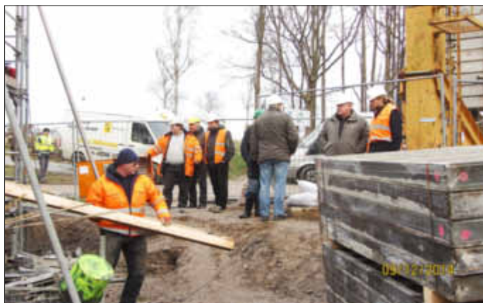
Die Schalung wird abgenommen.
