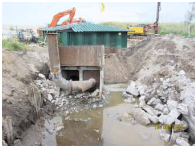
Vom alten Werk ist nur noch die Freiflutkammer zu sehen.
