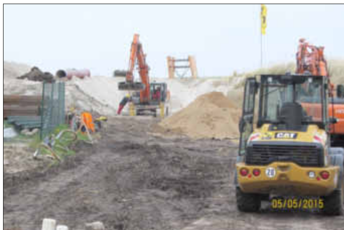
Im Vordergrund sind die Rohre schon zugedeckt, im Hintergrund werden sie erst in die Düne verlegt.
