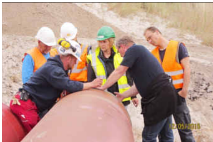
Begutachtung der Rohre für die Druckleitung
