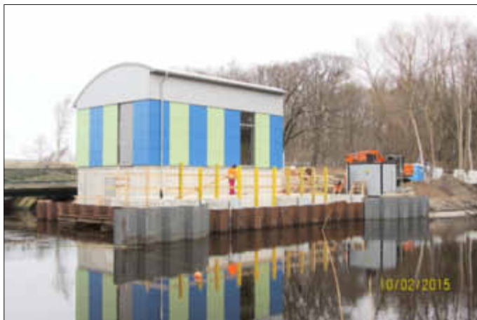
Baustelle Schöpfwerk vom Süden betrachtet
