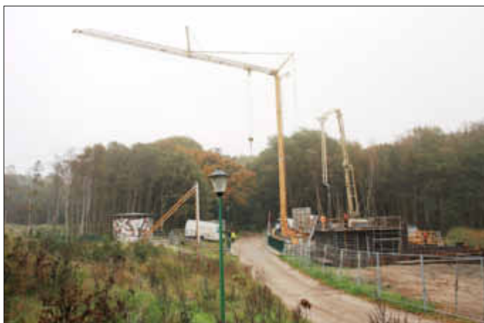
Der Beton wird in die fertige Schalung gebracht.
