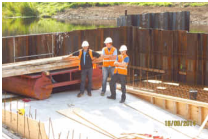
Die Kollegen der örtlichen Bauüberwachung (BDC Dorsch Consult Ingenieurgesellschaft mbH) sind bisher mit dem Bauablauf sehr zufrieden.
