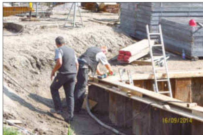
Komplizierte Verschaltungen erfordern maßgenaue Holzarbeit.
