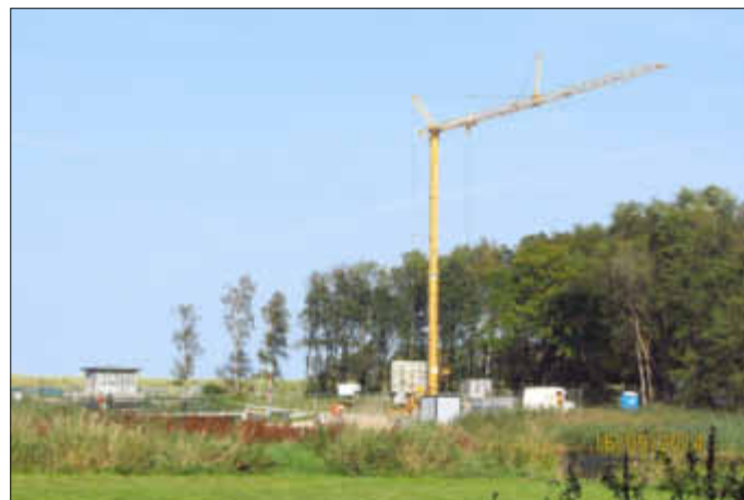
Blick vom Süden des Mahlbusen zur Baustelle.
