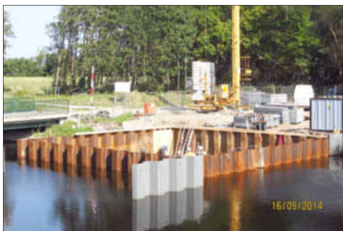
Momentan werden Verschalungs- und Betonierungsarbeiten auf der Fundamentplatte durchgeführt.
