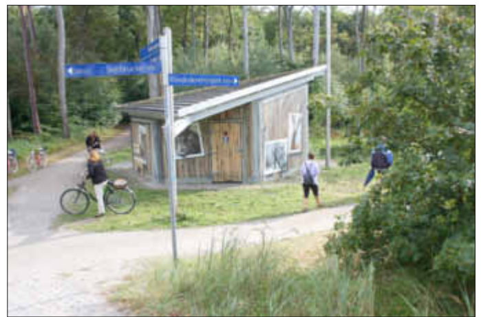
Blick von der Promenade auf das WC-Haus.
