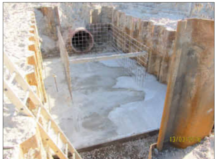
Baustelle: Verschluss des Druckrohres im Dünenfuß (ver- schwindet im Sand).
