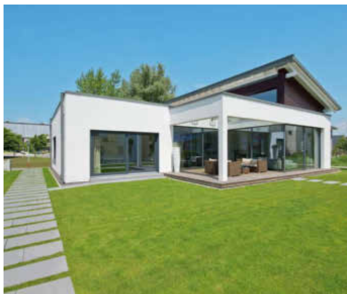
Komfortabel wohnen - auch im Alter. Mit der richtigen Planung ist das problemlos möglich. Foto: djd/WeberHaus.de
