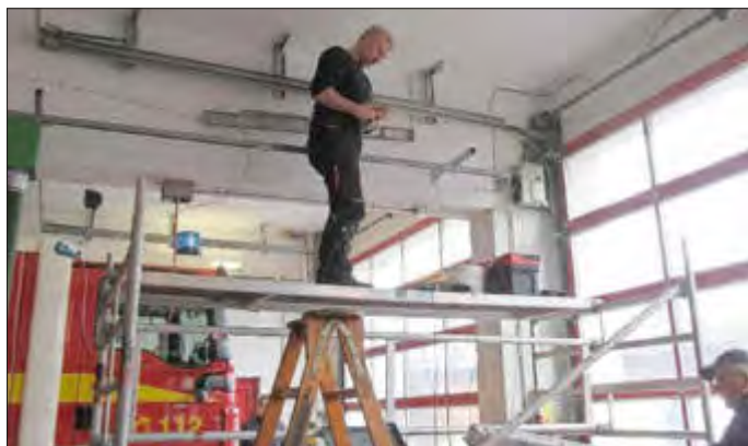
Das Montageteam im Einsatz.
