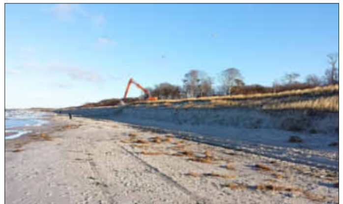
Erste Sicherungsmaßnahmen an der Düne und den Strandzugängen.
