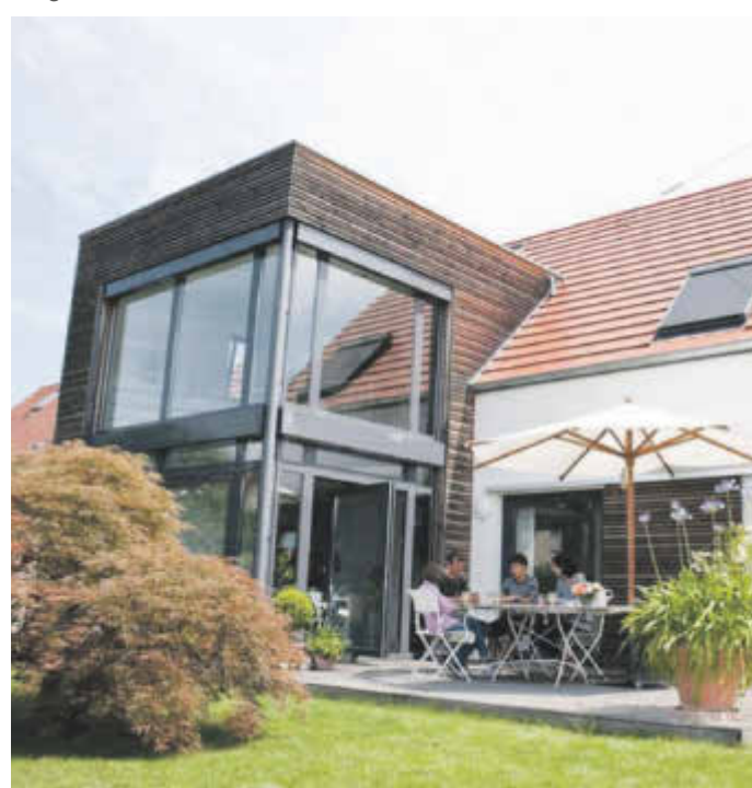
Nachhaltiges und umweltbewusstes Bauen liegt im Trend - von der Fassadengestaltung bis zur Wärmedämmung unterm Dach. Foto: djd/Paul Bauder
