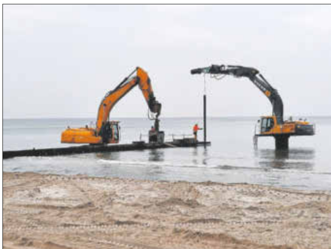
Der rechte Bagger rammt die Pfähle in den Meeresgrund, der linke schafft die Pfähle vom Strand zur Ramme.
