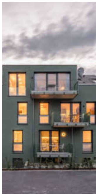
Eine Wärmedämmung der Fassade ist der erste Schritt zu mehr Energieeffizienz und einem geringeren Verbrauch im Zuhause. Foto: djd/Saint-Gobain Weber GmbH
