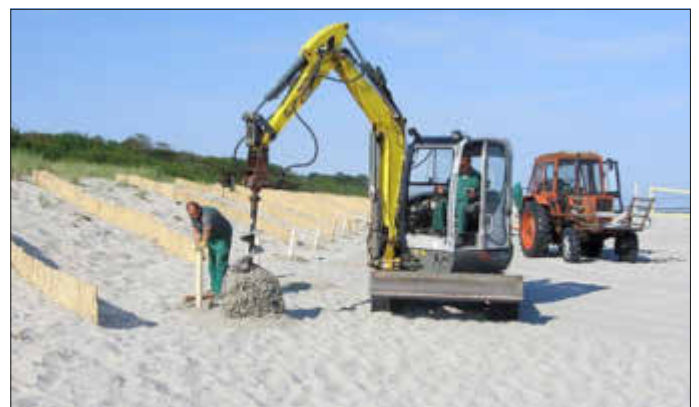
Die Drahtabspannung an Strandaufgängen und Dünenfuß wird angebracht.
