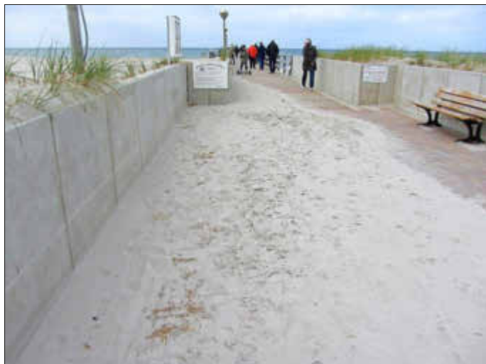
Versandete Seebrücke nach einem Sturm
