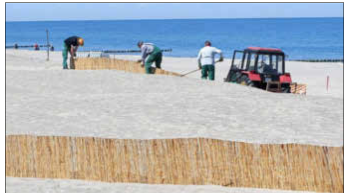
Sandfangmatten werden sturmsicher aufgestellt
