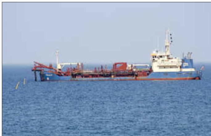
Rohrverlegung bei der Sandaufspülung
