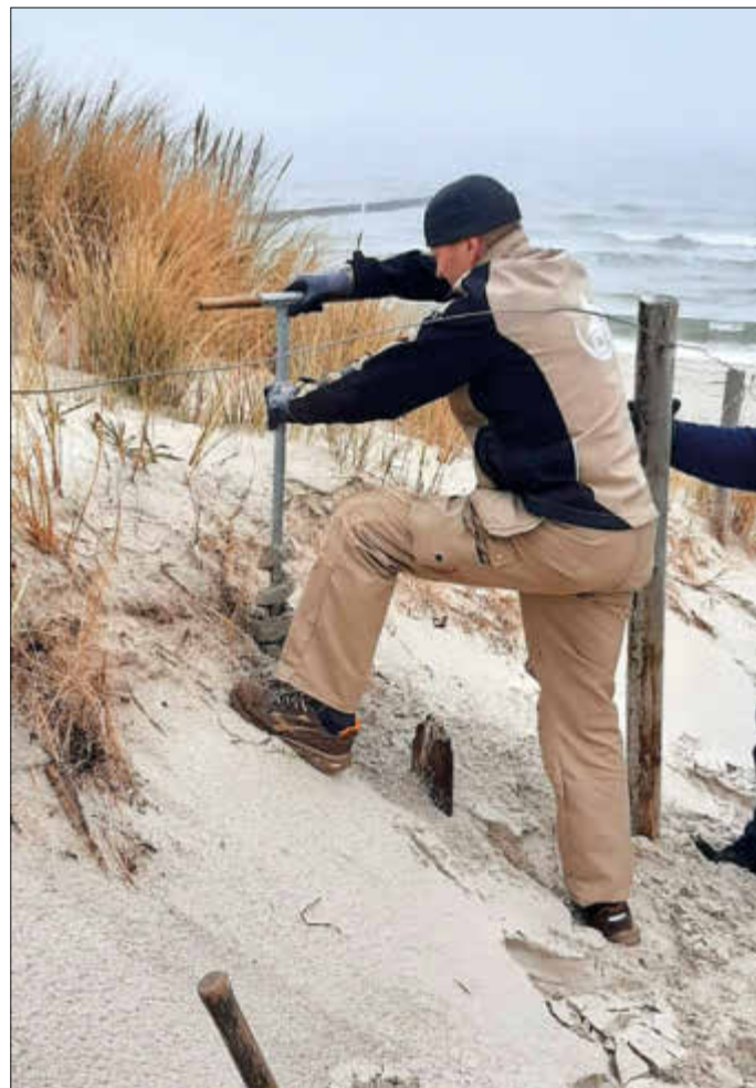
Setzen von neuen Pfählen.
