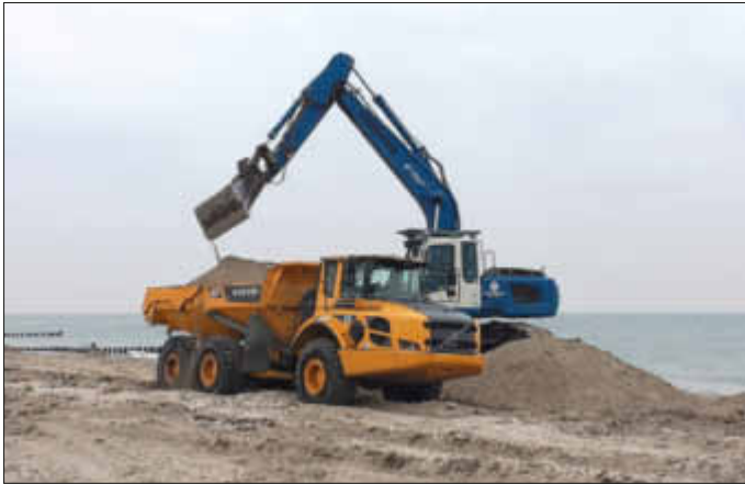
Der Bagger belädt den Muldenkipper.
