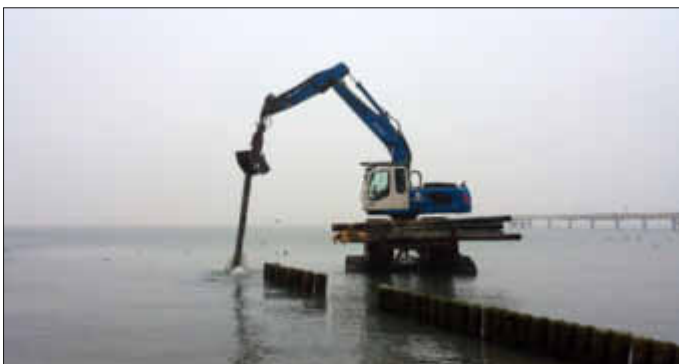
Die zerstörten Pfähle werden aus den Bühnen gezogen.
