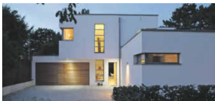
Dynamisches Duo: Für dieses Einfamilienhaus im Stil der klassischen Moderne kamen Kalksandstein und Porenbeton zum Einsatz. Foto: djd/Massiv mein Haus
