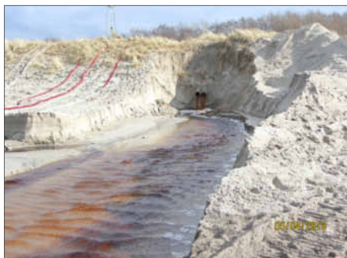
Zusätzlicher Auslauf des Moorgrabens in die Ostsee
