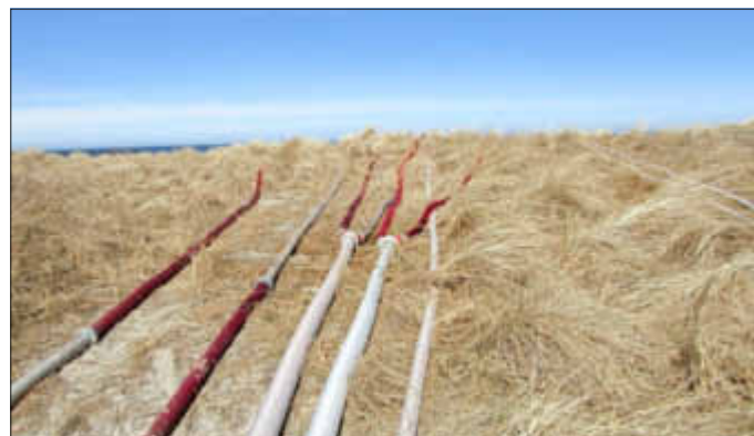
Schlauchleitungen vom Moorgraben über den Deich.
