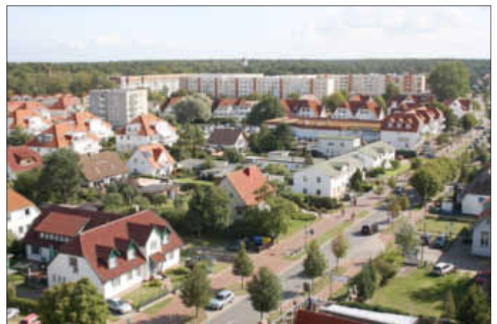
Blick zum Ostseering von der Drehleiter aus
