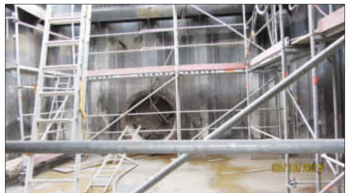
Blick in das Innere des Zwischenbehälters Anfang Oktober.
