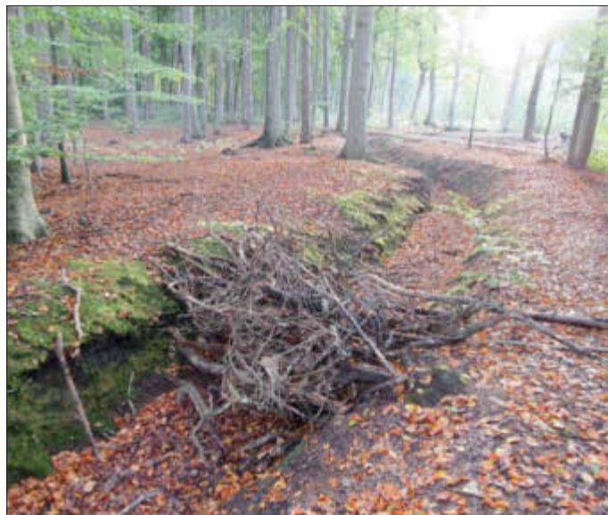
Das Wasser reist das Totholz mit und verstopft somit die Durchflüsse.
